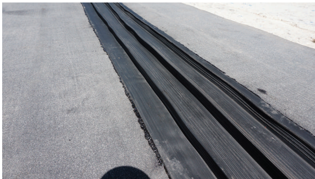
Рисунок 64 – Соединение Гидрошпонки ИКОПАЛ ХН-Б 200/25 с УЛЬТРАНАП
