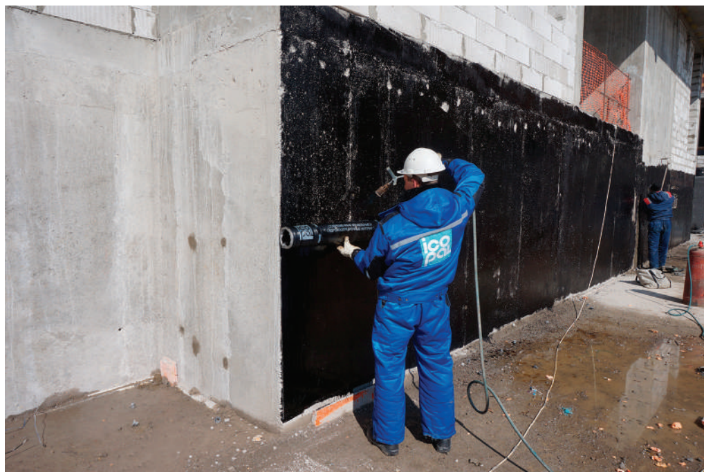
Рисунок 52 – Наплавление гидроизоляции на стену здания
