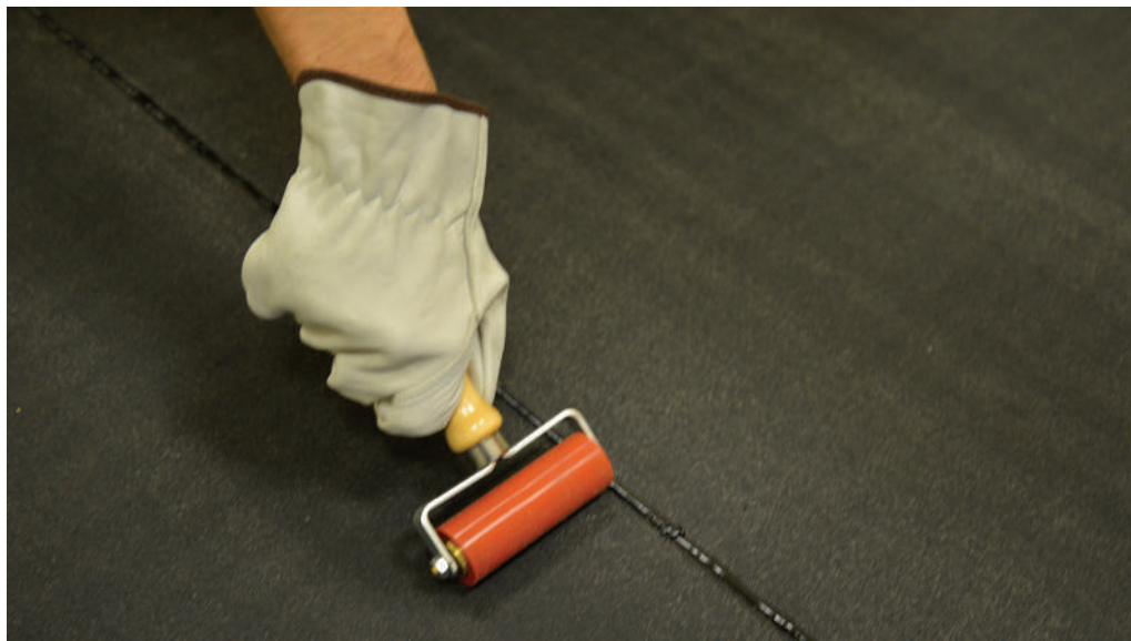
Рисунок 36 – Использование прикаточного ролика
