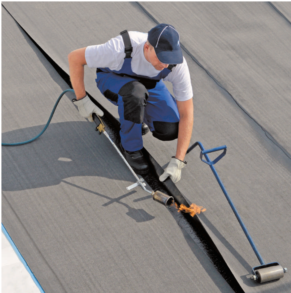
Рисунок 38 – Сварка продольных швов с использованием прижимного ролика
